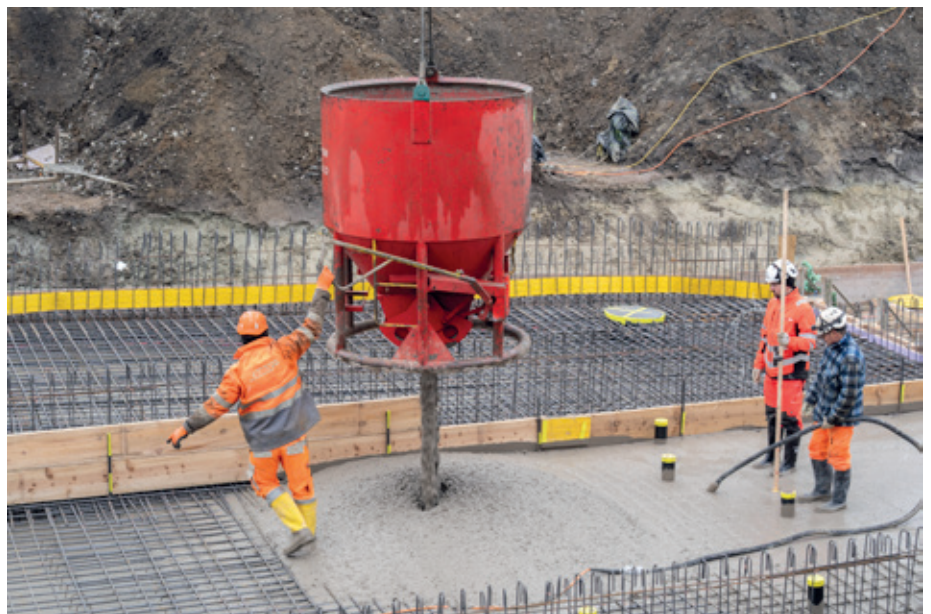
Ausheben, betonieren – die Siedlung Binzmühle ist am entstehen.
